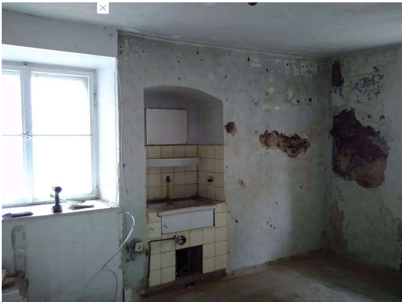
Foto: Susanne Pfeifer | Vor der Sanierung im Erdgeschoss sah es so aus.
