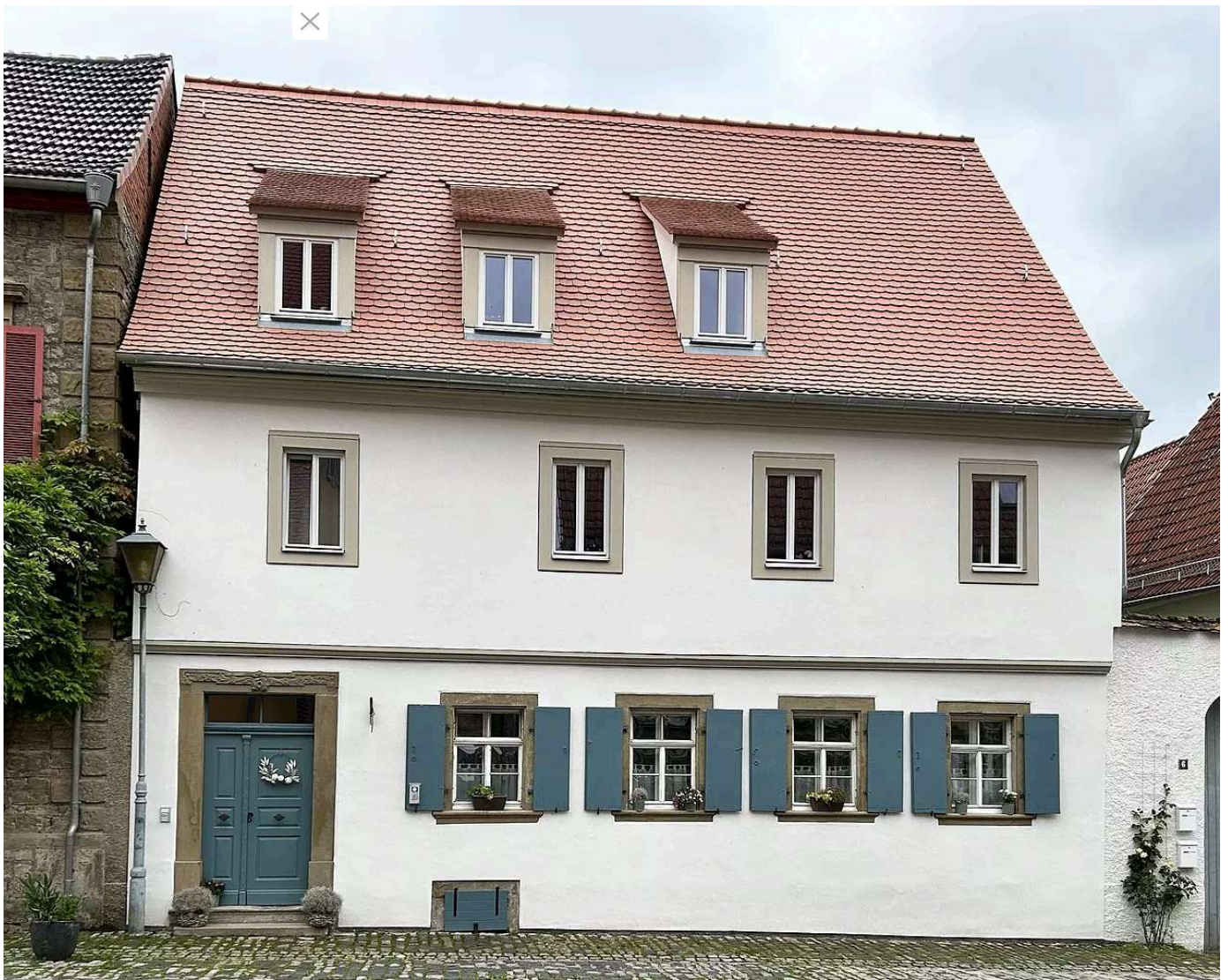
Foto: Susanne Pfeifer | Nach der Sanierung ist ein städtebauliches Schmuckstück entstanden. Susanne Pfeifers Wohnung liegt im Dachgeschoss. Das erste Obergeschoss ist vermietet, im Erdgeschoss befindet sich eine Ferienwohnung.
