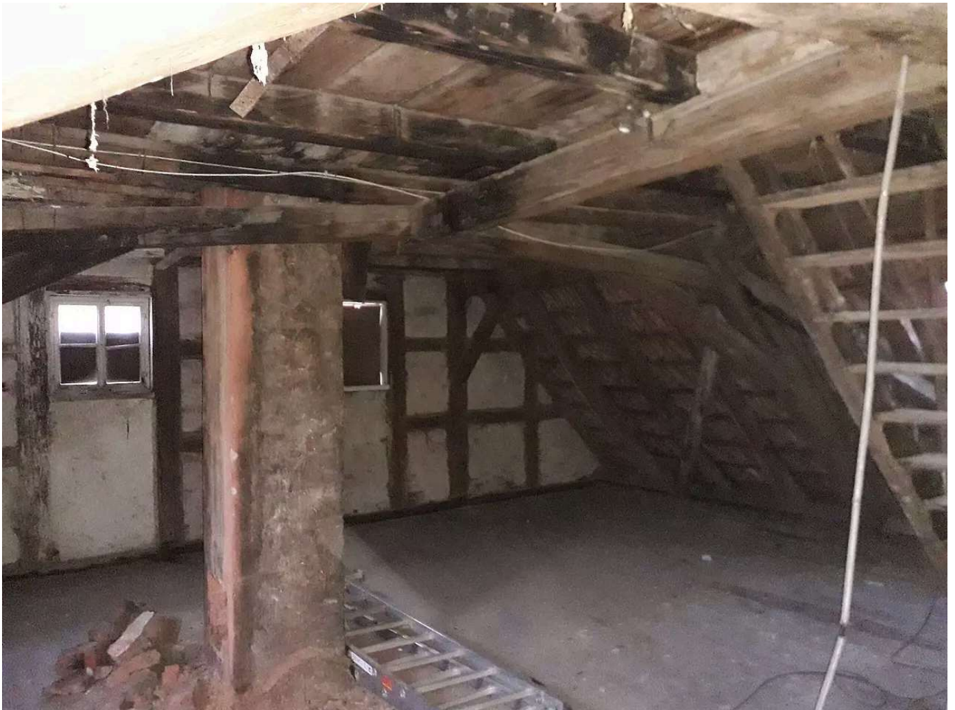
Foto: Susanne Pfeifer | Nicht gerade wohnlich wirkte das Dachgeschoss vor der Sanierung. Bei der Sanierung sollten möglichst alle brauchbaren vorhandenen Hölzer wiederverwendet werden, ebenso Türen und Fenster.
