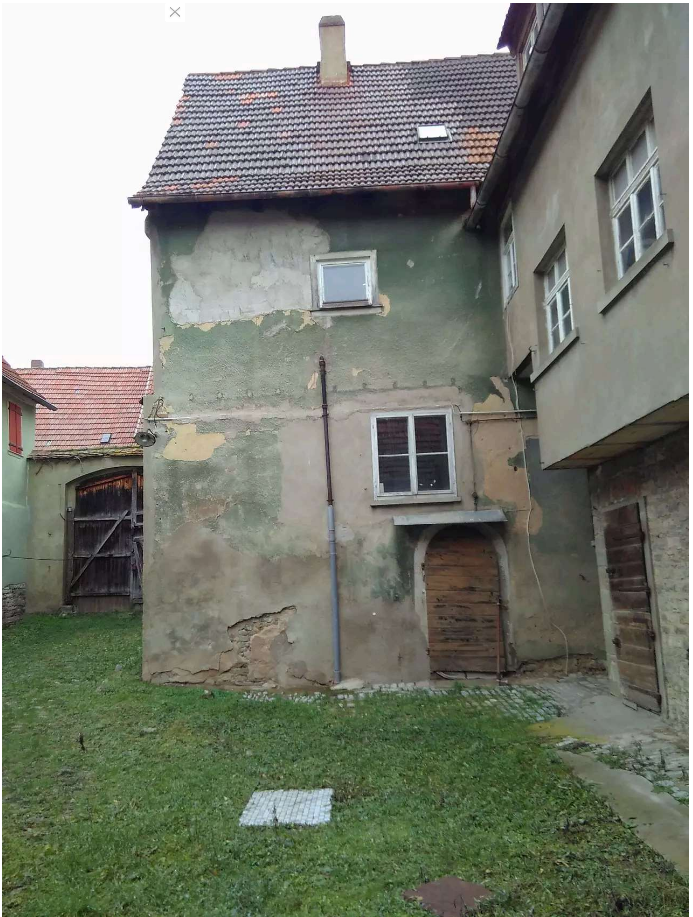
Foto: Susanne Pfeifer | So sah der Blick vom Innenhof auf die Gebäude vor der Sanierung aus.
